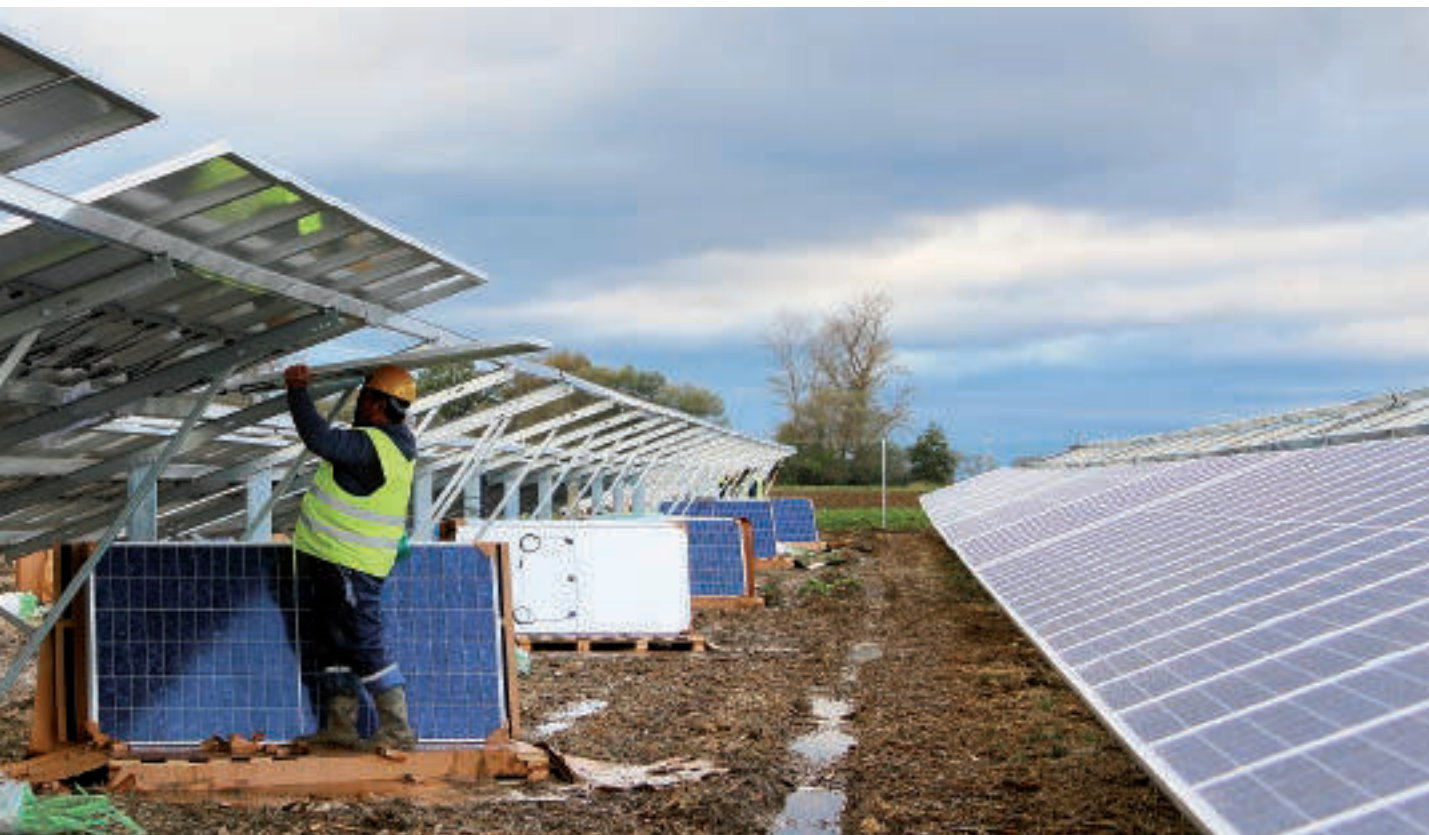
Plattling: Aufbau von 61.200 Solarmodulen
